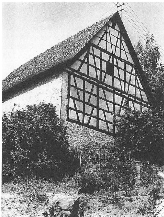
Ehemalige Pfarrscheuer – Südgiebel; 1991 abgebrochen
