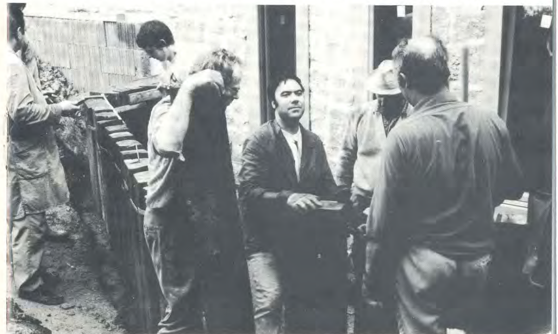
Pfullingen abgebaut wurde. Von dort sind die Eichen-Schwellen). Gemeinde-Angehörige machen Außen-Anlagen.
